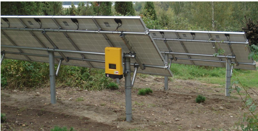
Ulos asennettu SMA Sunny Boy 2000HF verkkoinvertteri
